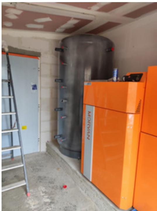
La chaufferie bois a été installée en remplacement d'une chaudière fioul et permet l'alimentation de deux bâtiments.
