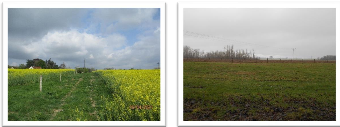
Photo 68 : Vue sur la ligne électrique aux abords du site à l'ouest (à gauche) et sur celle recoupant l'est du projet (à droite)
