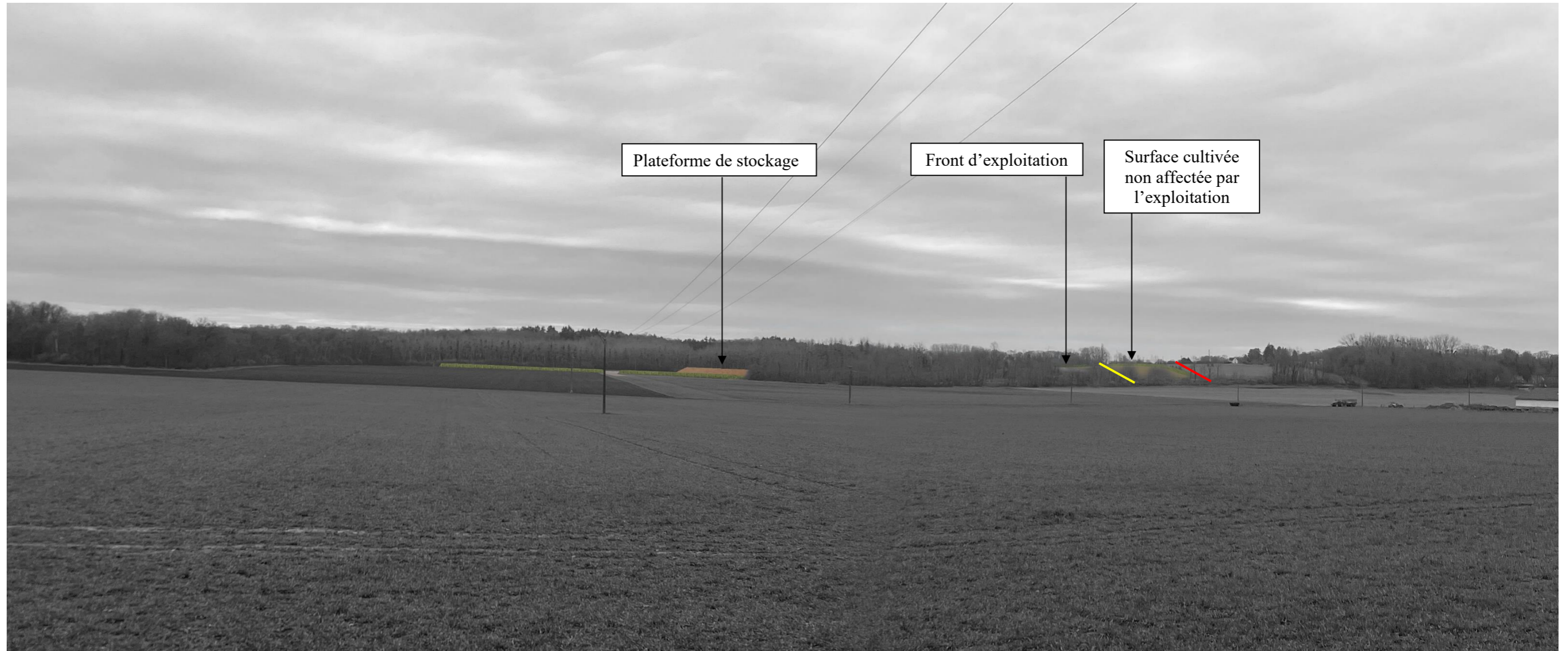
Figure 133 : Photomontage depuis la route menant de Cahaignes à Authevernes, point de vue n° 3 (Source : Atelier Atlante)
