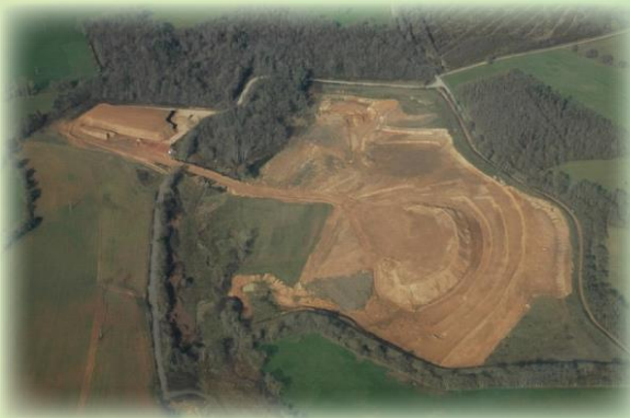
Carrière de sable argileux de Laplaud, Manot (16) en exploitation en 2014 (Source : Terreal)
